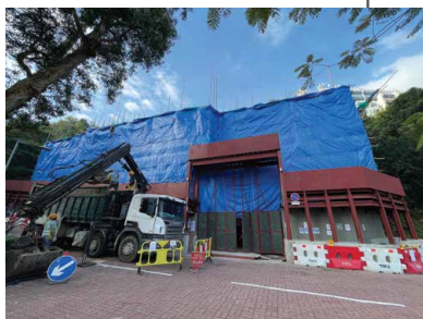
開始拆卸工程 Demolition Started
