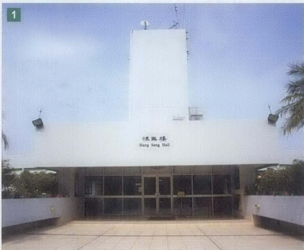
1 恆生樓五樓入口一貌。
