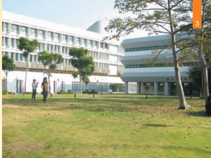
本院胡忠多媒體圖書館前草地已於2010年暑假進行翻土及重鋪草地工程，是次工程新增種植了溝葉結縷草及加建了灑水系統。綠草如茵，歡迎校友使用。
