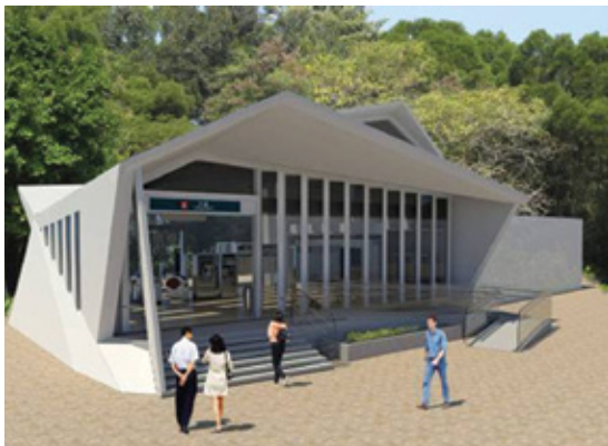
港鐵大學站增設北面出口
