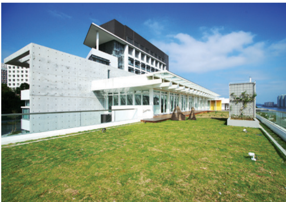
天台花園 Roof garden
