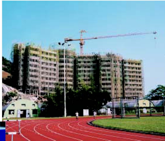
興建中的研究生宿舍（一九九八年） A postgraduate hostel complex under construction (1998)
