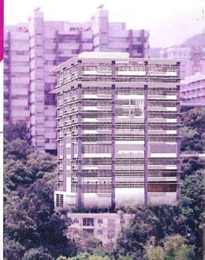
前：新工程學大樓(電腦模擬) 後：何善衡工程學大樓
