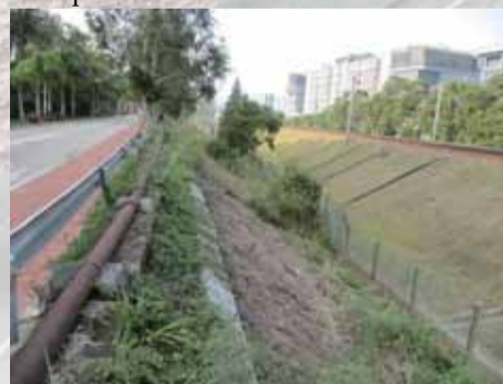
工程前 Before works
