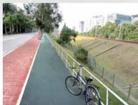
工程後 After works
