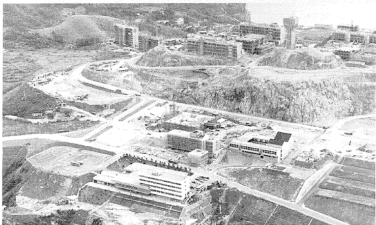
建設中的校園。范克廉樓（前）及中國文化研究所（中右）已經落成，大學行政樓、圖書館、聯合及新亞書院舍尚在施工（一九七一）。
