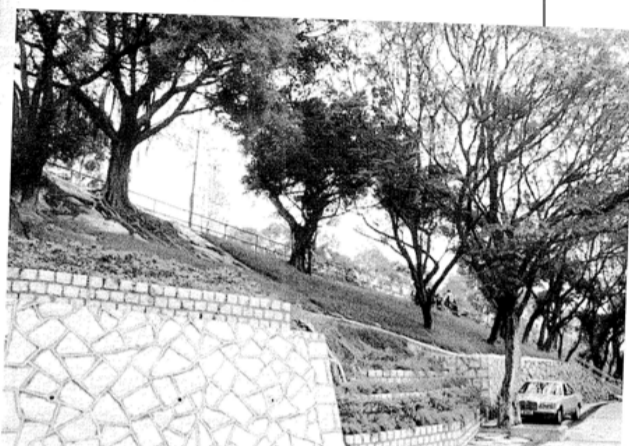
另一種綠化方法是在斜坡轉角位，按坡度附加梯階花槽，栽種植物。
