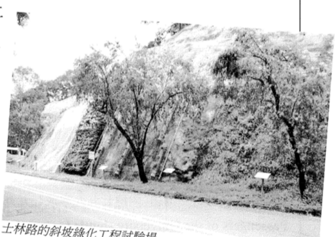
士林路的斜坡綠化工程試驗場
