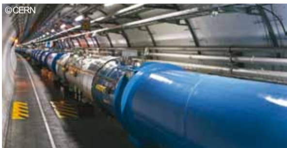
大型強子對撞機管道 LHC tunnel
