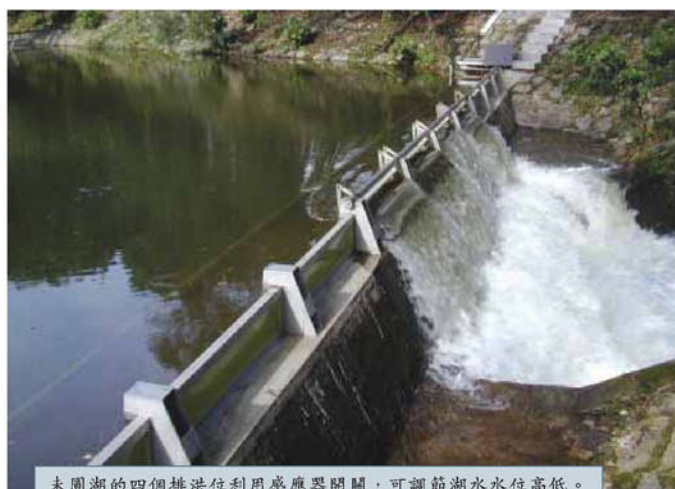
未圓湖的四個排洪位利用感應器開關，可調節湖水水位高低。 The automatic watergate in Wei Yuen Lake
