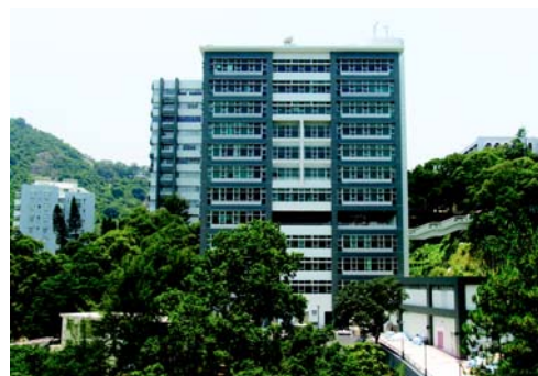
工程學大樓二期
