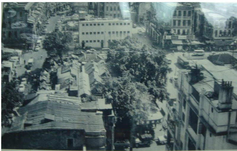
圖十. 早年由美都餐室鳥瞰拍攝之榕樹頭全景；圖正中樹木、矮房覆蓋處即為榕樹頭，圖左處為廟街，圖右處是上海街，榕樹頭後面的建築物是今日街市街公廁座落處
