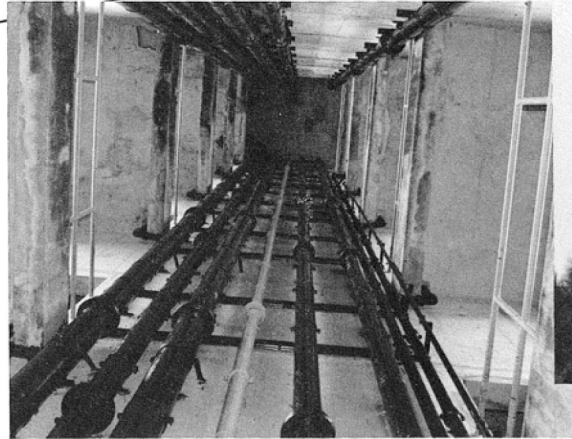
自塔底仰望的水塔內景
