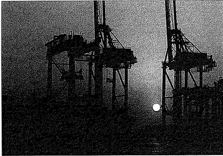
12月10日，國家重大戰略工程洋山深水港正式開港，洋山保稅港區封關啟用。這標誌著上海國際航運中心建設取得重大突破。洋山深水港建成的一期工程，包括港區工程、東海大橋、蘆潮港輔助配套工程。碼頭岸線總長1,600米，東海大橋總長32.5公里。資料、圖片來源： http://www.jfdaily.com.cn/
